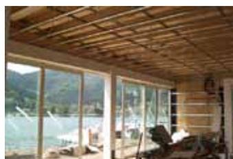
Sopra, l'interno del ristorante con ampia vetrata sul fiume Magra. La struttura del primo impalcato è costituita da un'orditura di travi di legno di larice, sulle quali è realizzato il solaio composto da coibentazione in sughero, da doppio tavolato incrociato e avvitato e pavimentazione in doghe di cemento resinate.
